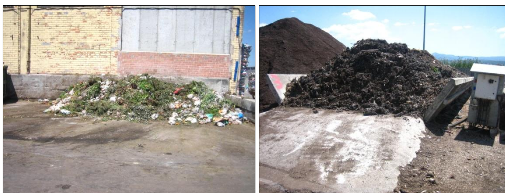
Imatge 1 Planta de compostatge en mòduls de la Mancomunitat.
