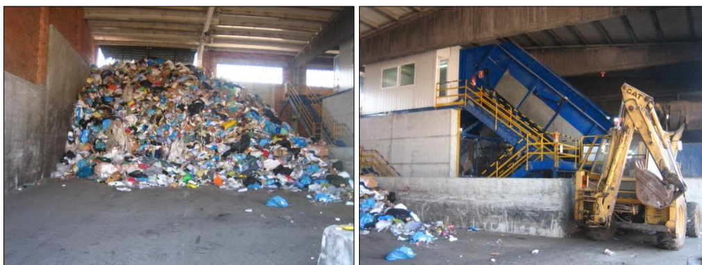
Imatge 3 Planta de triatge de la Mancomunitat.
