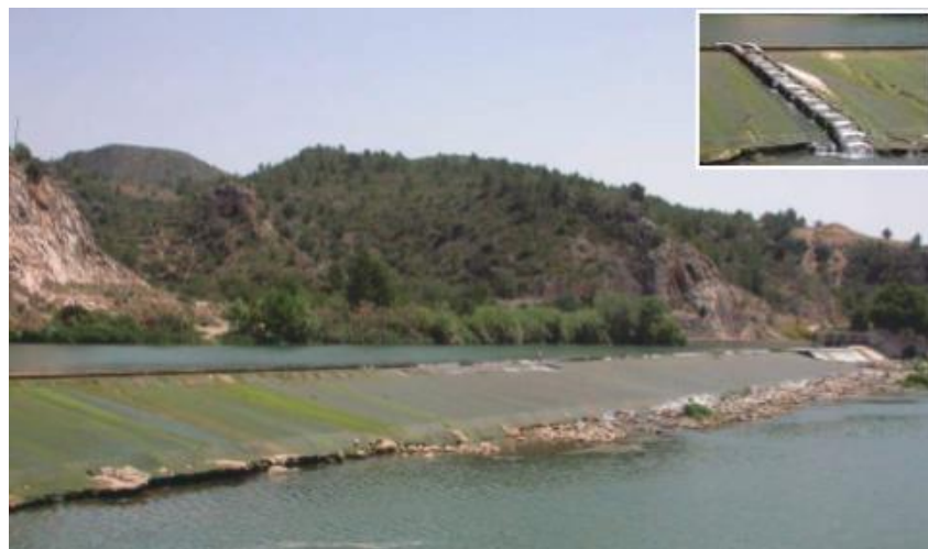
Figura 2. Solució de rehabilitació: dispositiu de pas per a peixos a l'assut de Xerta-Tivenys, per tal de millorar la connectivitat per als peixos al riu Ebre. Font: Atlas dels peixos del Delta de l'Ebre, de López et al. (2012).
