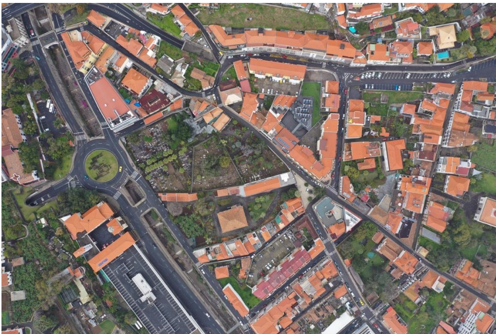
Figura 21. Fotografia de drone: Rotunda dos bombeiros municipais até à Rua da Carreira.
