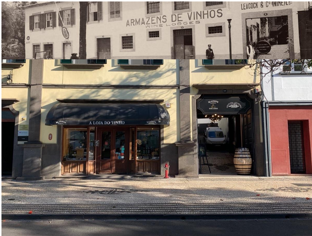
Figura 75. Sobreposição entre o mesmo edifício das Arcadas de São Francisco em 1925 e 2021. 24
