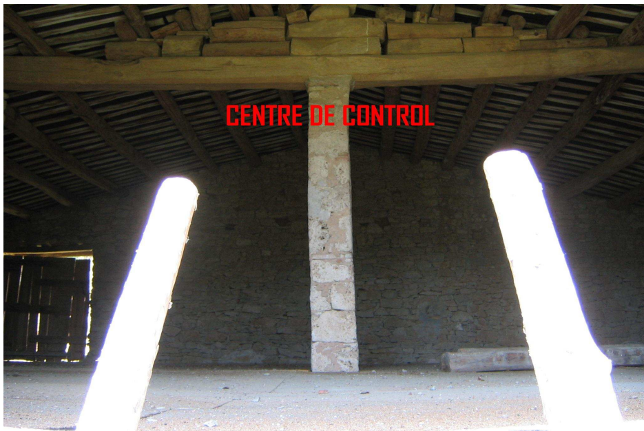
Figura 51- Ubicació del centre de control exterior (juny del 2005)
