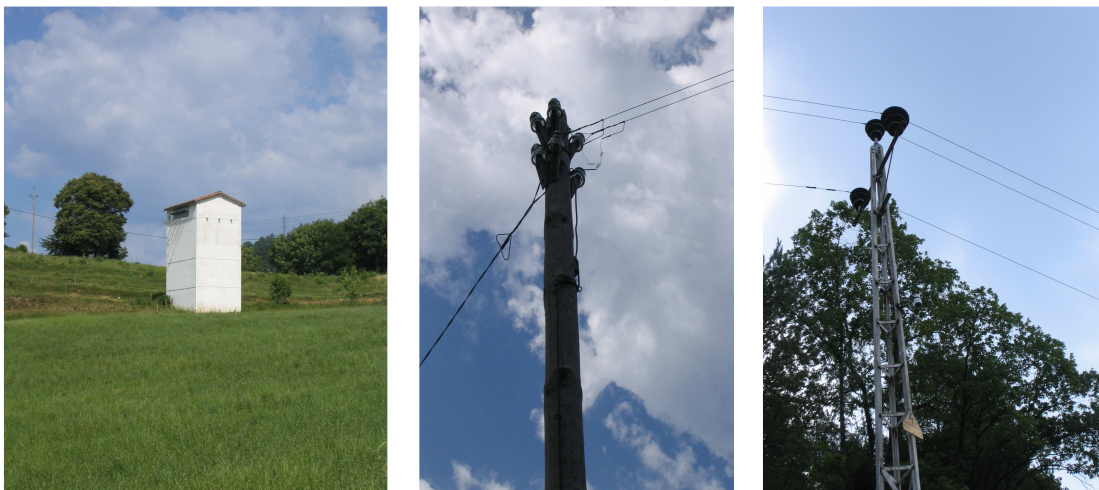
Figura 19- Fotografies de la xarxa elèctrica en les proximitats de Puigvassall
