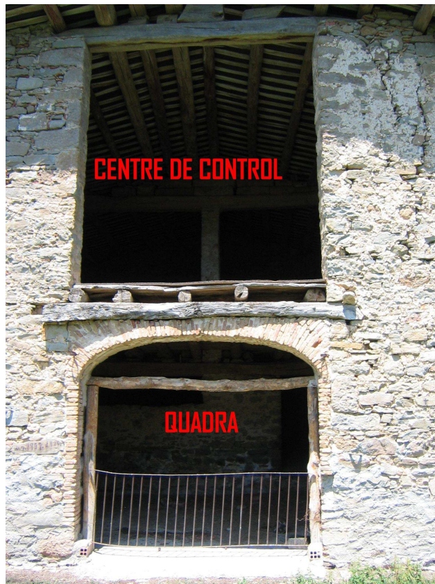
Figura 48- Cobert de Puigvassall (juny del 2005)
