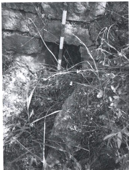
Derivació optativa d'aigües del torrent Salat vers la bassa.
