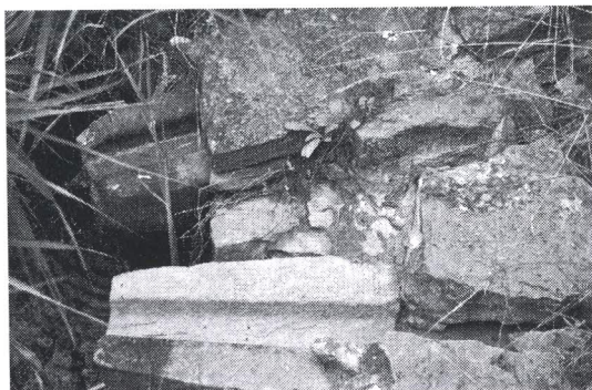
Tram superior de la mina. Sota l'enllosat del pis transcorre la canonada ceràmica. A la dreta, els dos brolladors de la sortida de les dues probables mines. El brollador de dalt, fosc, rajant, i l'altre brocal, el més proper, sec des de fa anys.
