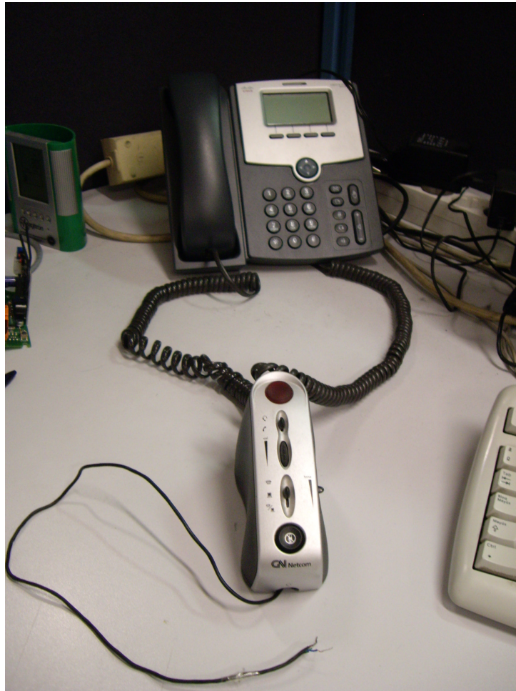
Imatge 17 Connexió de la xarxa telefònica a la placa de recepció
