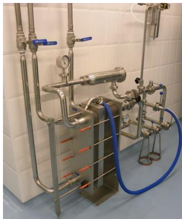
Fig 17: Refredador de plaques de la microcerveseria Naparbier
