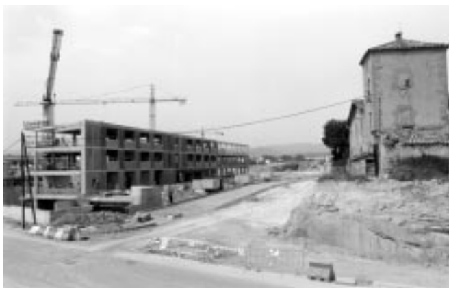
Obres a la torre dels Frares.
