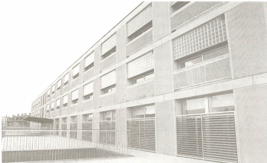
Vista de l'Edifici de l'Escola Politècnica Superior en l'estat actual.
